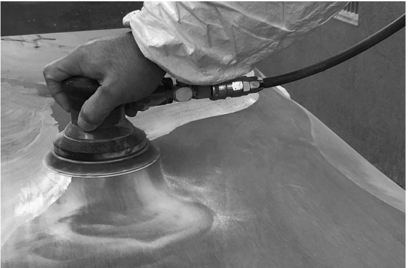
樹脂の部分の高い透明度、木の部分の滑らかな触り心地を作り出す最後の工程です。職人の手によって時間をかけ何段階もペーパーの粗さを変え丁寧に研磨していきます。通常一枚板の倍以上の時間をかけることで樹脂部分の透明度は非常に高くなり、神秘的な美しさが生まれます。
