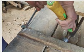
建具パーツの解体作業も基本的な手作業です。
